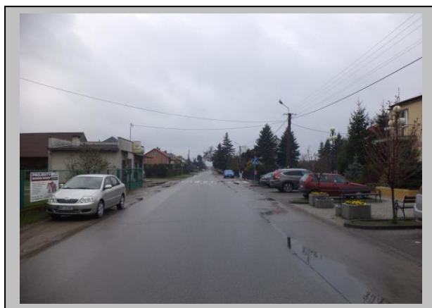
Zdjęcie nr 2. (krótka infor.) Droga powiatowa 1811W w m. Zabrodzie – odcinek od urzędu gminy do szkoły podstawowej
